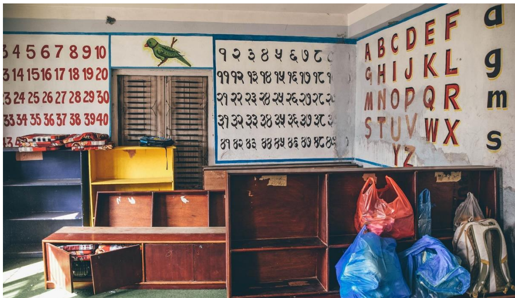
5 Vor dem Umbau
